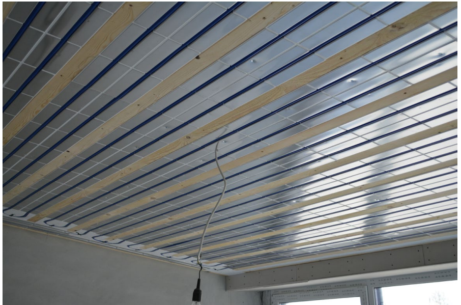
Abbildung 17: Montage der Registerbauweise mit Befestigungsebenen aus Holzkonstruktionen an einer Decke; Quelle: BDH
